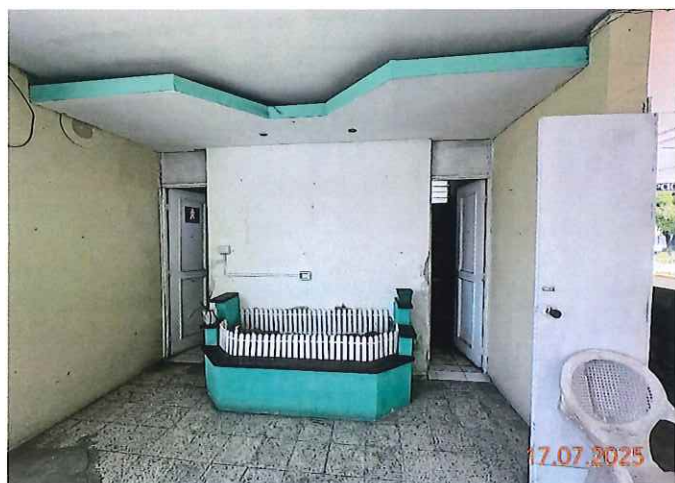
Área de sanitarios del restaurante.
