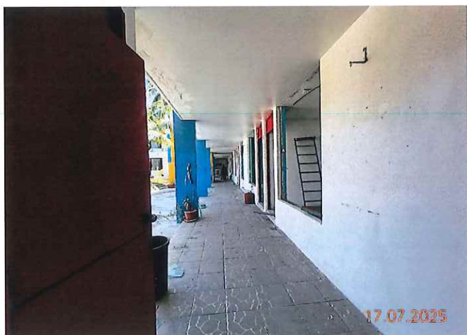
Pasillo de circulación.
