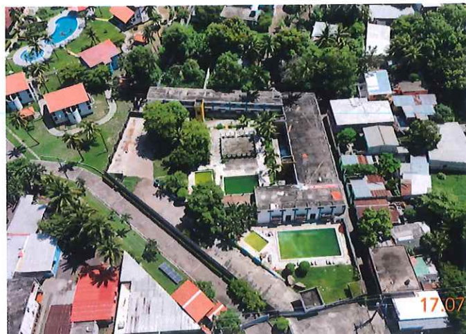
Vista aérea general del inmueble.
