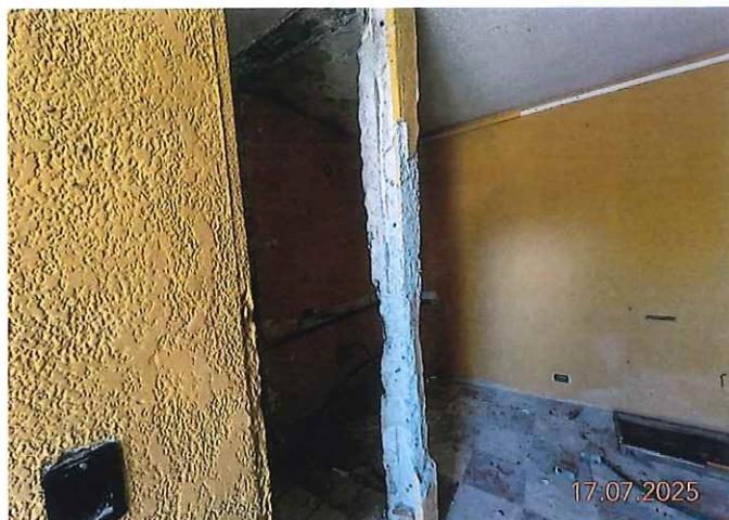
Habitación con área de baño. Divisioes internas parcialmente demolidas.
