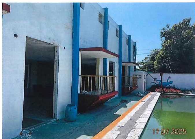
Fachada frontal del área de restaurante.
