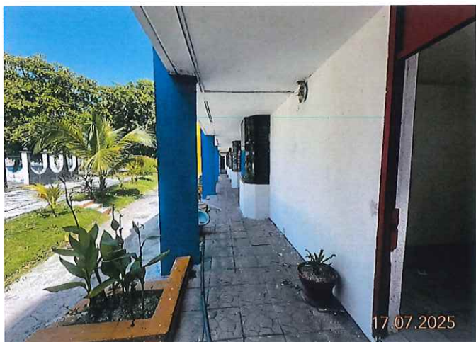
Pasillo de circulación.
