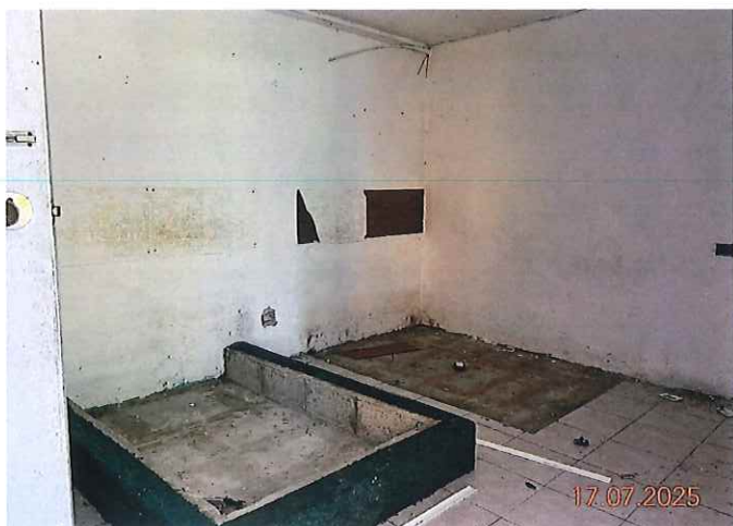
Habitación con área de baño. Bases para cama fundidas in situ.
