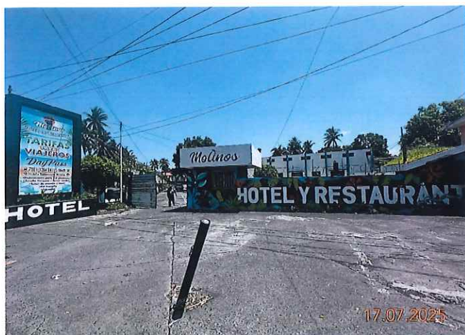
Área de parqueo frontal.
