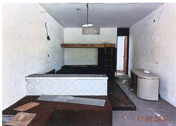
Habitación con área de baño. Mobiliario fundido in situ.
